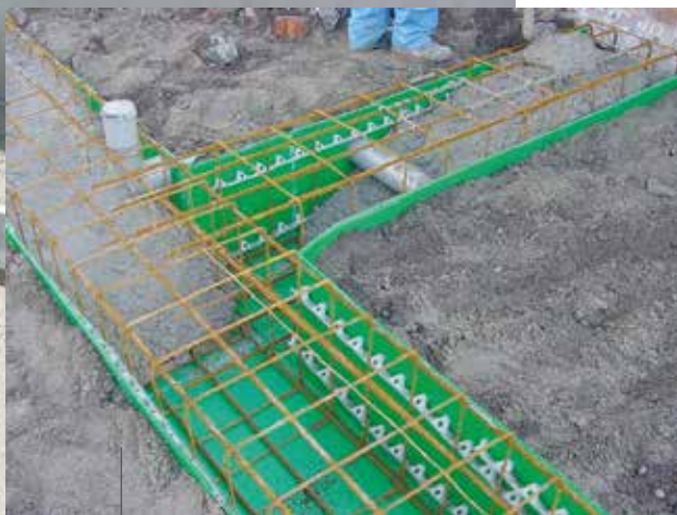
revestimiento de hormigón
